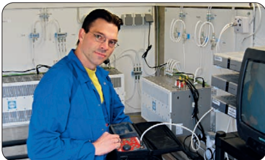
Bild 2: Martin von Hoeble installiert die neue Kopfstellentechnik
