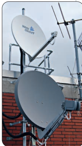
Bild 3: Zwei Antennen empfangen alle gewünschten Programme über die Satellitenpositionen Hot Bird 13° Ost und Astra 19,2° Ost
